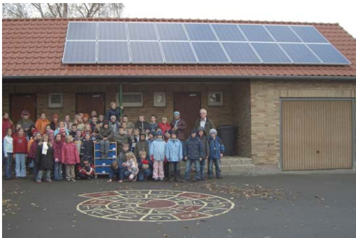
Die 4 kW p – PV- Anlage der Grundschule Barienrode im Landkreis Hildesheim.
